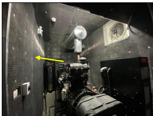
รูปที่ 35 ฉนวนป้องกันเสียงภายในห้องเครื่องกำเนิดไฟฟ้า
