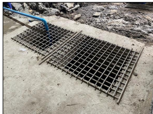
รูปที่ 18 ตะแกรงปิดคลุมบริเวณที่มีการเปิดพื้นที่หน้าดิน
