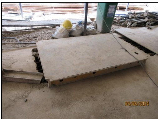
รูปที่ 18 ตะแกรงปิดคลุมบริเวณที่มีการเปิดพื้นที่หน้าดิน
